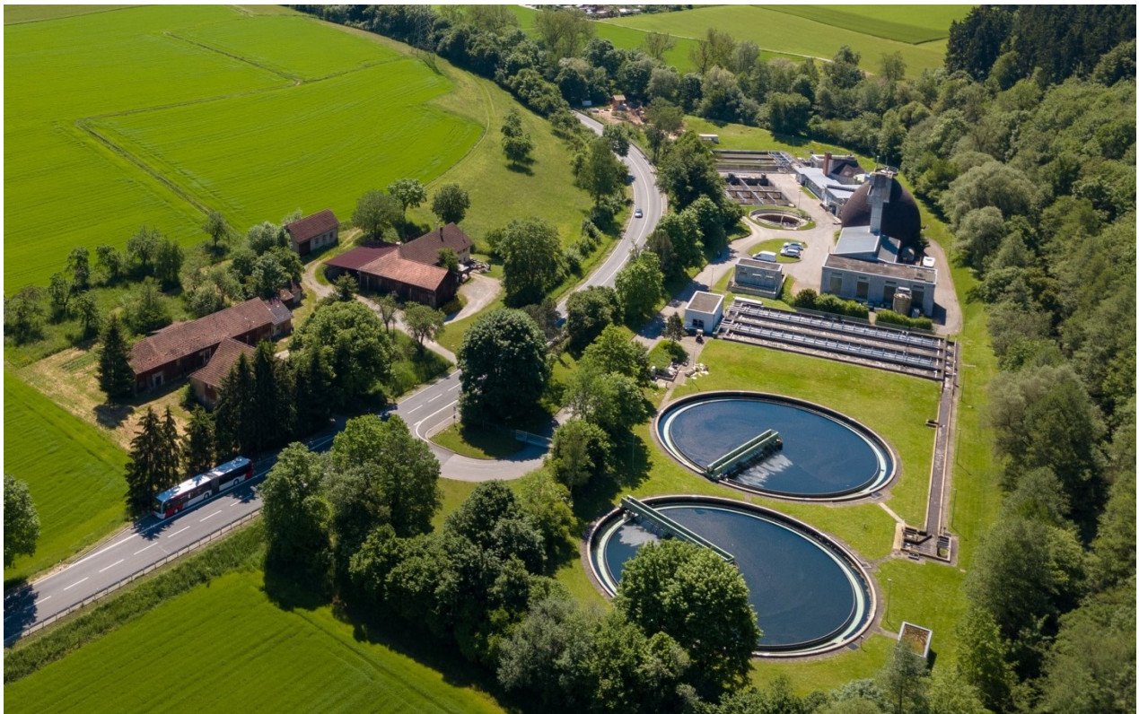
Luftbild Kläranlage vorne die beiden Nachklärbecken
